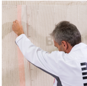
Armeerimisvõrgu Baumit CeramicTex paigaldamine
