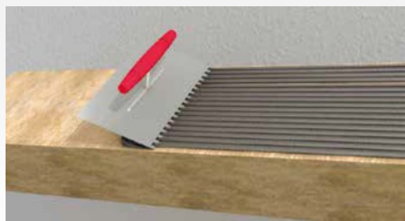
Täispinnaline liimimismeetod – kogupinnaline liimühendus
